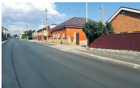
Ремонт ул.4-я линия, с.Чалтырь
