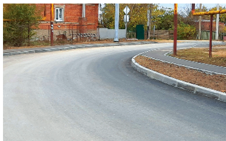
Капитальный ремонт ул.Донская и ул.Беляева, х.Калинин
