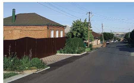
Ремонт ул.Налбандяна, с.Чалтырь
