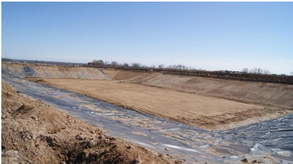
Рисунок 8 - Устройство защитного экрана.
